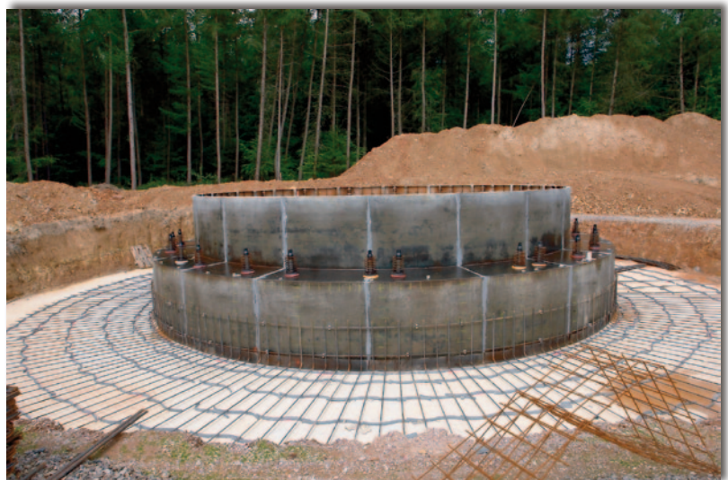
...dafür sind massive Betonfundamente herzustellen...
