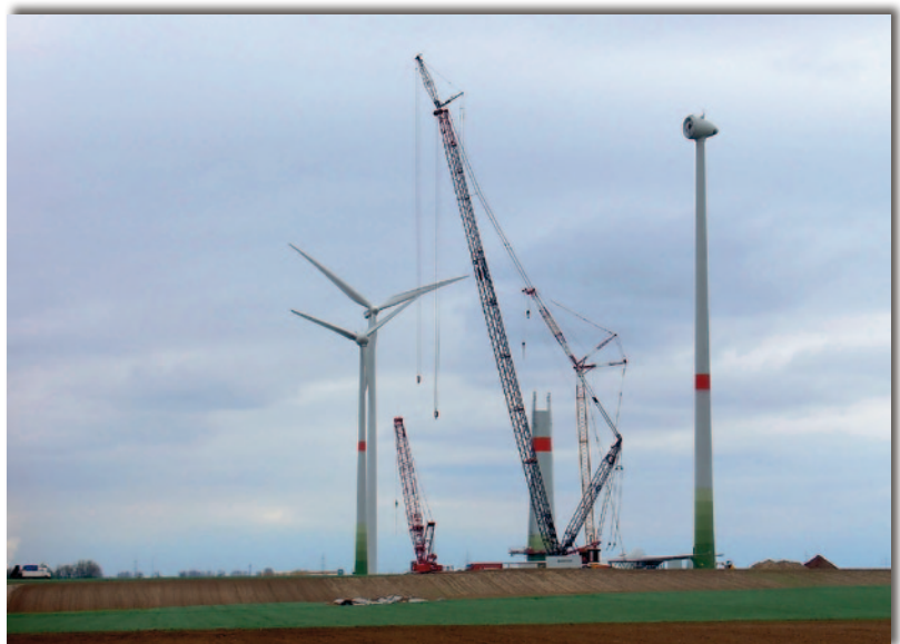
Eine typische Windkraft-Baustelle
