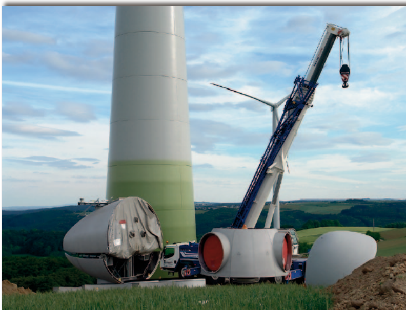
Die Nabe eines Windrades wird montiert.
