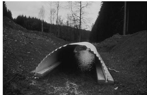
Das Rohr und die Flügelmauer sind entfernt, das zur Sohle offene Stahl-Sonderprofilbauwerk ist eingebaut und wird in einem nächsten Arbeitsschritt übererdet. Fotos: Autor
