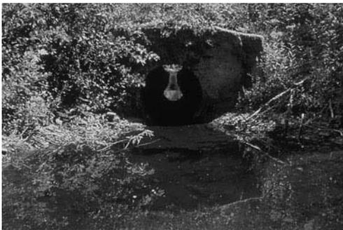
Eine schwere Flügelmauer sichert dieses Betonrohr, welches zur Gewässerquerung in einen mit Schwerlastverkehr befahrenen Holzabfuhrweg eingebaut ist.
