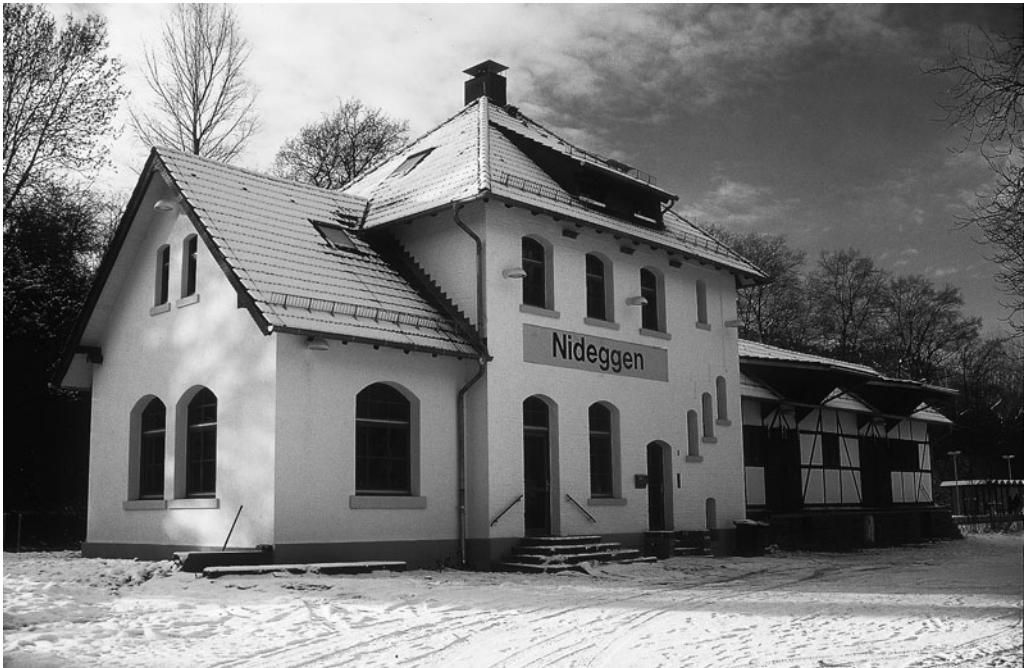
Das neue Domizil der Biologischen Station wurde mit vielen baubiologischen „Extras“ ausgestattet und renoviert.
