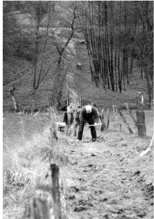
Mitglieder der OG Sötenich bei der mühsamen Sanierung des HWW 6.
