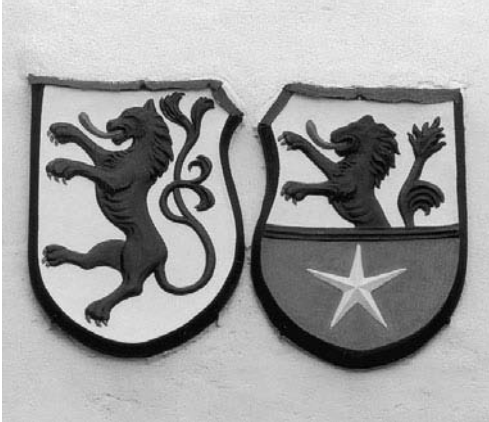
Restaurierungen so weit das Auge reicht. Hier das von der OG Bad Münstereifel erneuerte Jülicher- und Stadtwappen am Werthertor.
