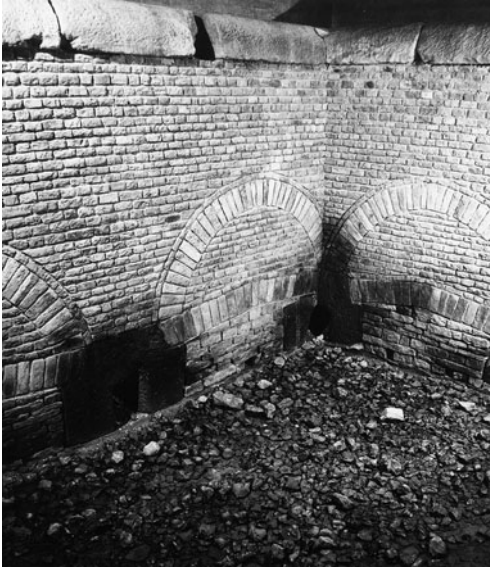
Römische Eifelwasserleitung nach Köln. Quellfassung Klausbrunnen bei Mechernich-Kallmuth.
