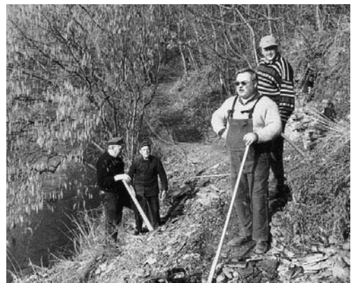
Viel Mühe machte die Sanierung des Ahrtalweges von Bad Neuenahr-Ahrweiler bis Rech. Foto: Autor
