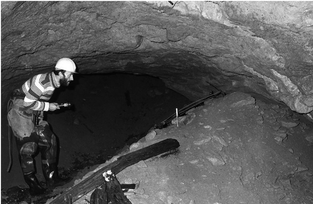
Der Fulbert-Stollen ist heute nicht mehr zugänglich. Das Bild zeigt die Einsturzstelle am südlichen Ende des Tunnels.
