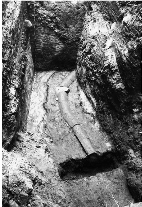
Im Drover Berg-Tunnel war eine mit Dachziegeln abgedeckte Steinrinne als Leitung verlegt worden.
