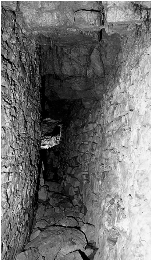
Tiergarten-Tunnel Blankenheim. Der Tunnelabschnitt zwischen den Bauschächten V und IV vor der Freilegung.
