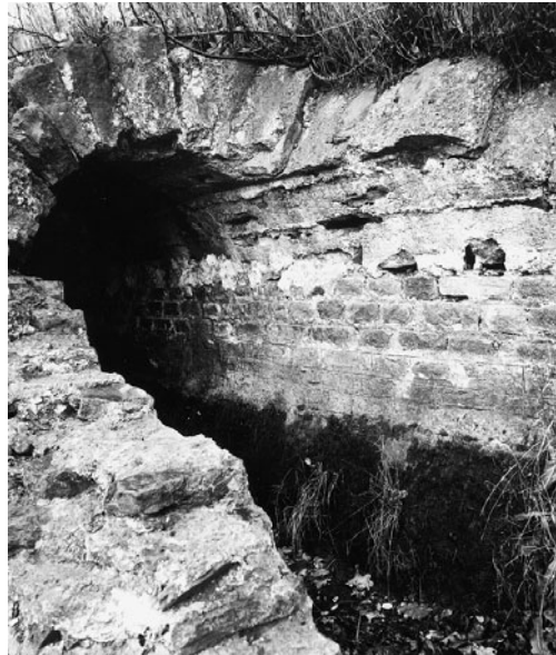
Römische Eifelwasserleitung nach Köln. Der Blick in die Leitung zeigt deutlich die Abdrücke der Schalbretter des Lehrgerüsts für das Gewölbe.
