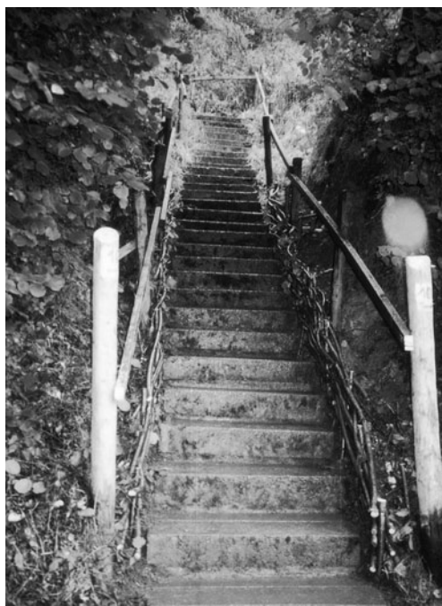
... oder bei der Sanierung der Treppe im „Helligisch“.
