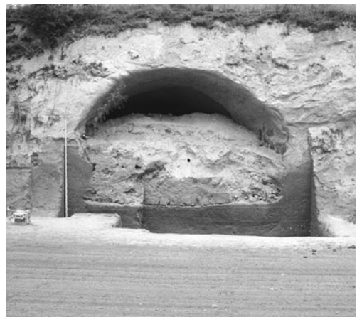
Abb. 2 – Altes Trassbergwerk unter der B 256 bei Plaidt. Erst durch den tiefgreifenden Bims- und Tuffabbau 1970/71 traten die unterirdischen Gänge des Stollensystems ans Tageslicht. (Foto: Vulkanpark GmbH)
