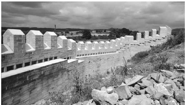
Abb. 5: Die Mauer am Katzenberg während des Wiederaufbaus. Ihr Verlauf ist dem unebenen Gelände angepasst. (Foto: Vulkanpark GmbH)
