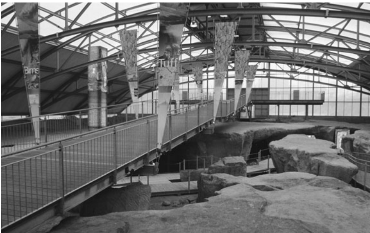
Abb. 4 – Das römische Tuffbergwerk Meurin wird durch eine freitragende Dachkonstruktion geschützt. Dies ist notwendig, da der Bims, der den unterirdischen Steinbruch einst meterhoch überdeckte und somit schützte, in moderner Zeit abgebaut wurde. (Foto: Detlef O. Mielke)
