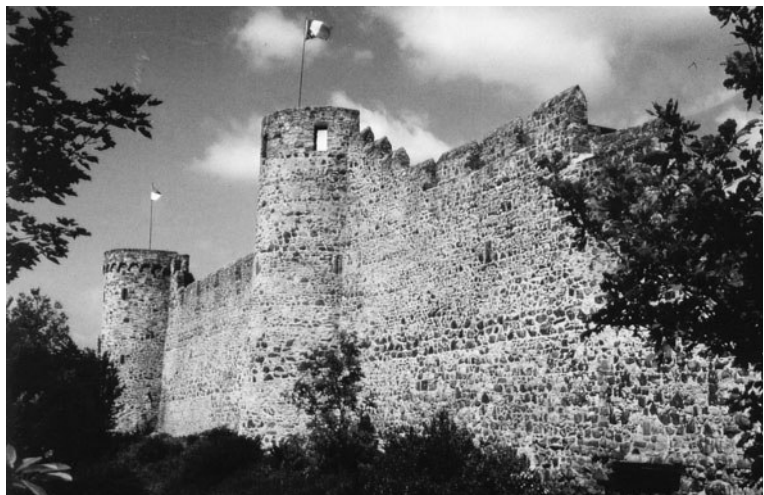
Stadtmauer in Hillesheim Foto: TI-Hillesheim
