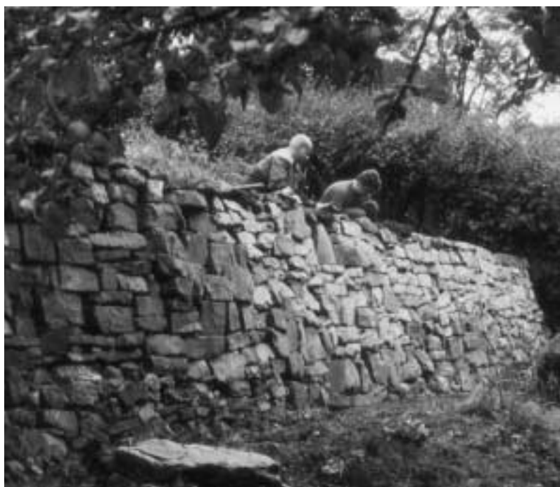
OG Kronenburg. Eine Trockenmauer wird wieder aufgebaut, 3 m hoch und 1 m dick.
