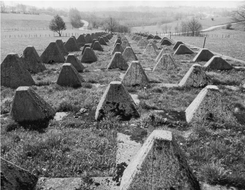
Simmerath. Mehrreihige „Betonhöcker“ im Westwall sollten damals die heranrollenden Panzer aufhalten.
