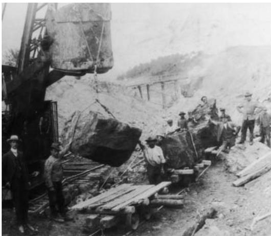
**Blankenheim.** Dampfhammereinsatz („... und es waren mehrere im Einsatz“) beim Bau der oberen Ahrtalbahn 1910–1913 (Station 17).
