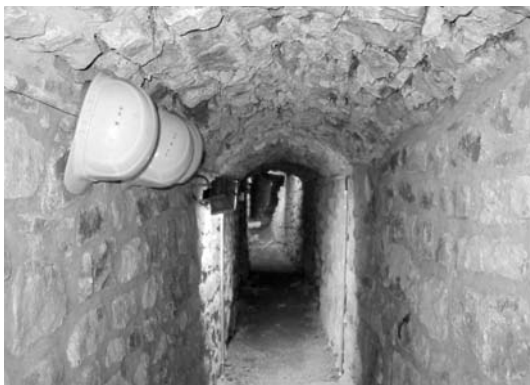
Blankenheim. Eingang zum Tiergartentunnel.
