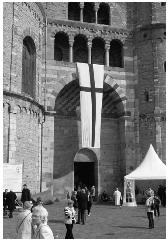
Trier. Die um Mitte des 11. Jh. errichtete Westfassade des Trierer Domes zählt zu den Hauptwerken der salischen Baukunst. © Andy May
