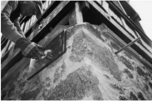
OG Brohltal. Mit Hilfe von Zugankern wurde die Mauerkrone stabilisiert. © H. Wellershaus
