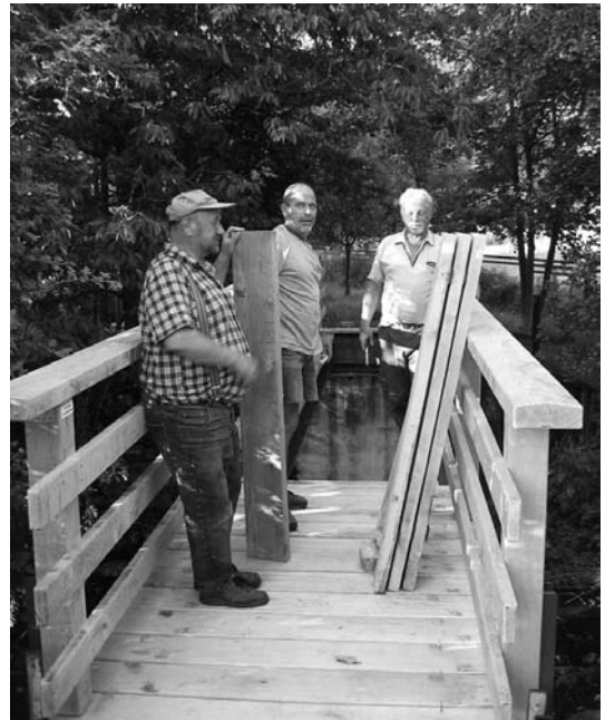
OG Reifferscheid. Unser Bild zeigt die Mitglieder des Eifelvereins beim Aufbau der Brücke. Die Materialien, insbesondere die schweren T-Träger, wurden mit einem Spezialtransporter sowie mit einem Kran an Ort und Stelle gefahren und platziert. © M. Hamacher
