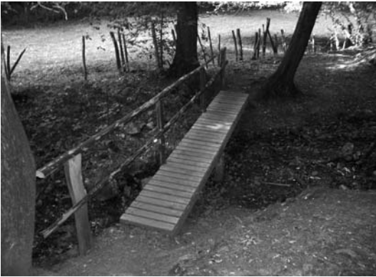
OG Rott. Der neue Fußgängersteg
