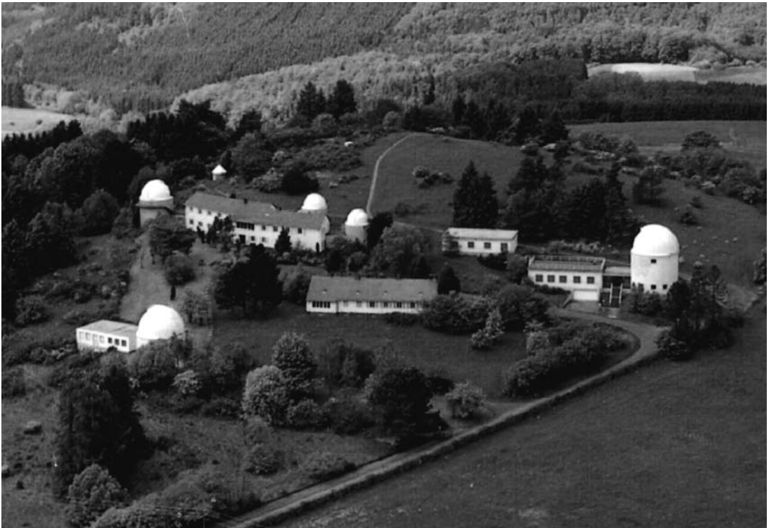
Daun. Gesamtansicht des Observatoriums Hoher List. Links oben erkennt man das Hauptgebäude mit seinen drei angebauten Kuppeln und in der Mitte das Wohnhaus, alles 1954 fertiggestellt. Aus der zweiten Bauphase von 1964/65 sieht man rechts die Kuppel des Bonner Doppelrefraktors mit der Feinmechanischen Werkstatt und links unten die Kuppel des 1m-Spiegelteleskops mit dem Elektroniklabor. © Obs. Hoher List
