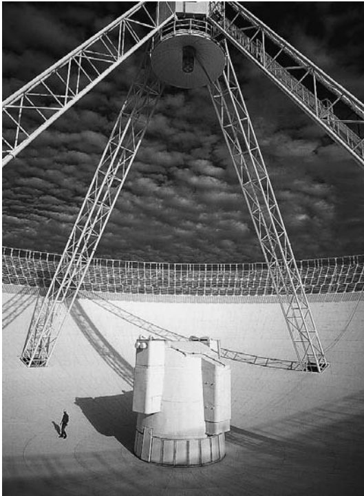
Bad Münstereifel. Der Teleskopspiegel mit den beiden Empfängerkabinen: Primärfokus an der Spitze der vier Stützbeine und Sekundärfokus im Zentrum des großen Spiegels. © MPIfR
