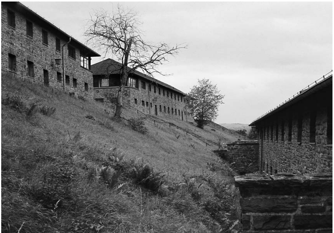
Mannschaftshäuser, Ansicht von Osten
