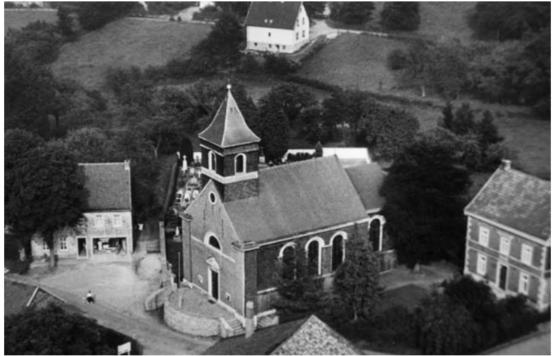
Kath. Pfarrkirche Rott von 1836
