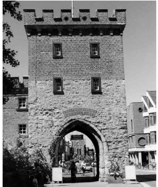
Der Oberbau des Bonner Tores, eines der beiden Stadttore Lechenichs, wurde 1853 restauriert und als Gefängnis eingerichtet, heute eine reizvolle Gastronomie.
