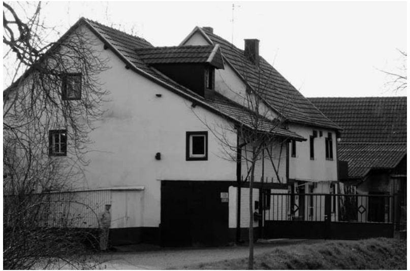
Friesheimer Kornmühle. Das Mühlengebäude enthält noch eine völlig intakte Einrichtung. Das eiserne, unterschlägige Wasserrad ist ebenfalls erhalten.
