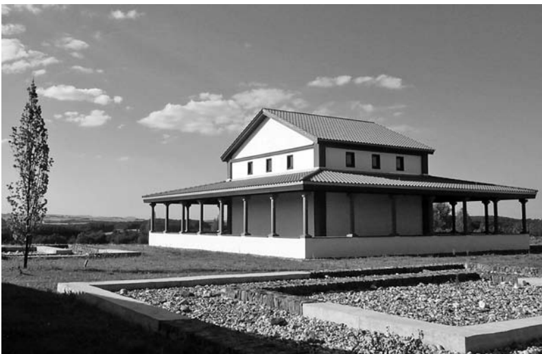
Treis-Karden. Die rekonstruierte Tempelanlage auf dem Martberg ist über den Moselhöhenweg zu erreichen. © Verkehrsamt Treis-Karden
