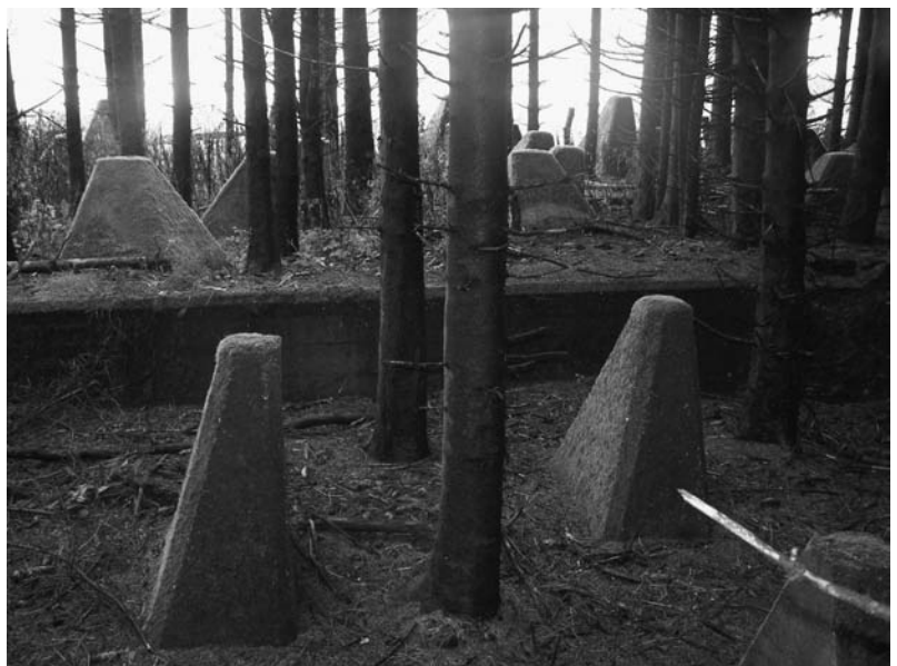
BG Vulkaneifel. Noch an vielen Stellen in der Eifel sind Reste der „Höckerlinie“ des Westwalls zu erkennen. © Bossmann
