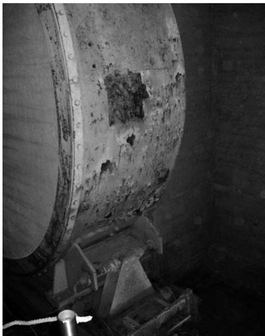
**Bad Neuenahr-Ahrweiler.** Solche Rolltore schützten die Bunkereingänge gegen Druckwellen bis zu 100 Atü.
