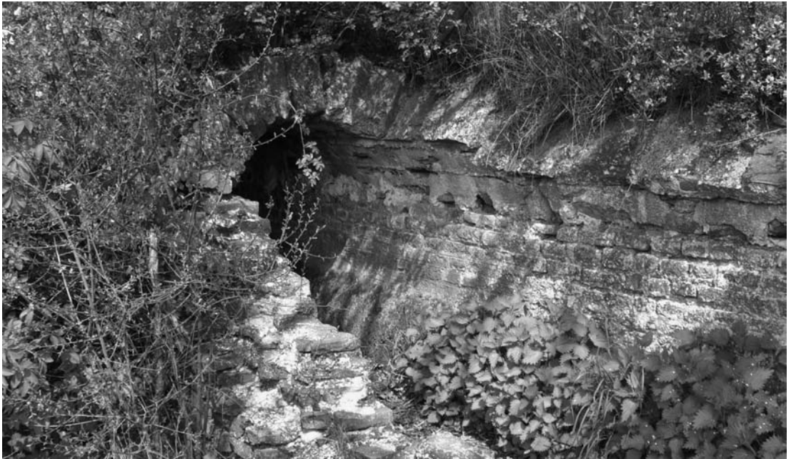
Der Aufschluss der römischen Wasserleitung bei Mechernich-Breitenbenden zeigt Abdrücke des Lehrgerüsts beim Gewölbekonstruktion und Fugenstriche als Zierfugen an der Innenwand.
