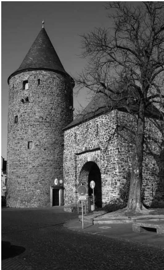
Im Wasemer Turm in Rheinbach ist massenhaft Römerkanal-Abbruch wiederverbaut worden.
