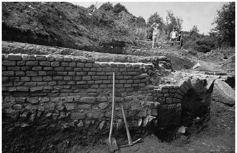
Aquäduktbrücke Mechernich-Urfey/Vollem im Grabungsbefund
