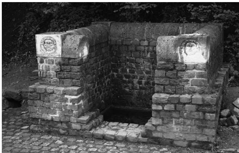
Der Grüne Pütz. Quelfassung am von Köln entferntesten Punkt des Römerkanals.
