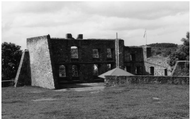
Ruine der 1689 zerstörten Oberburg der Ritter von Ulmen.
