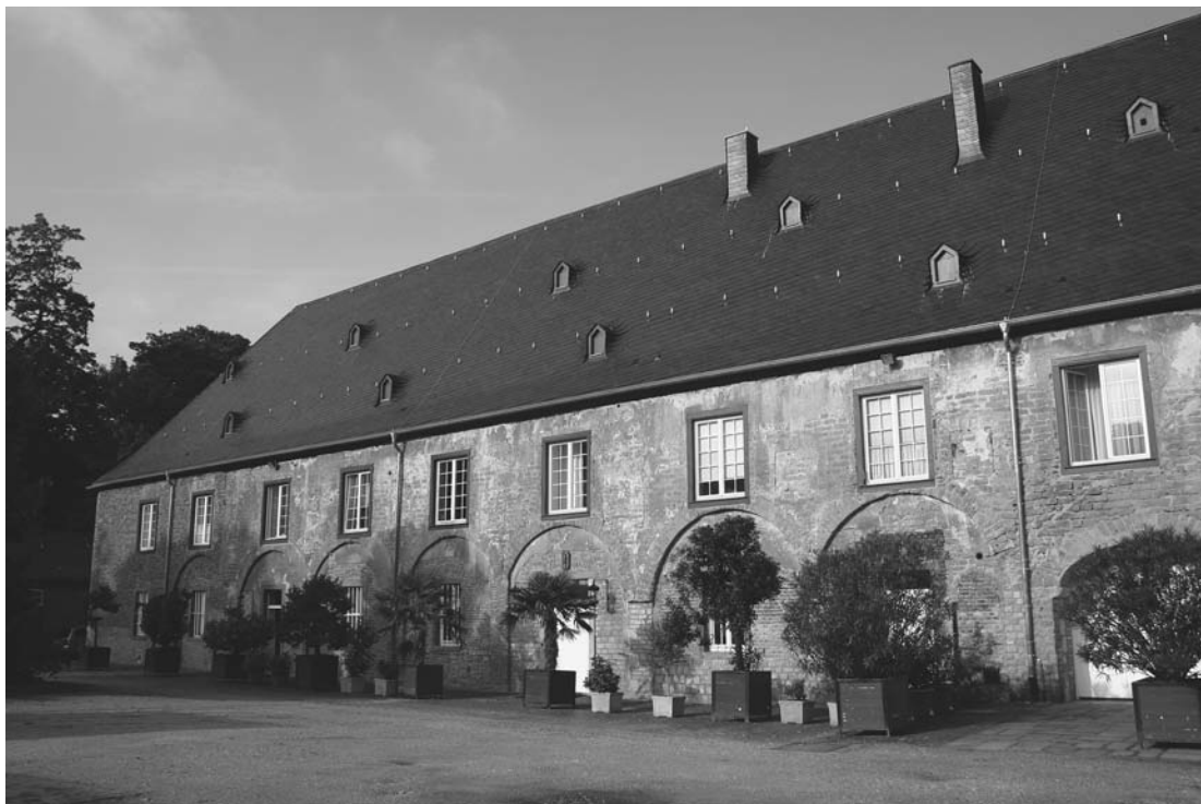
Beim Bau des Klosters Schillingskapellen (heute: Gut Kapellen) hat man in erheblichem Maße Abbruchmaterial des Römerkanals wieder verwendet; im ehemaligen Kreuzgang sind die Bögen der Aquäduktbrücke nachempfunden worden. © Fotos und Zeichnungen: K. Grewe, Rheinische Bodendenkmalpflege
