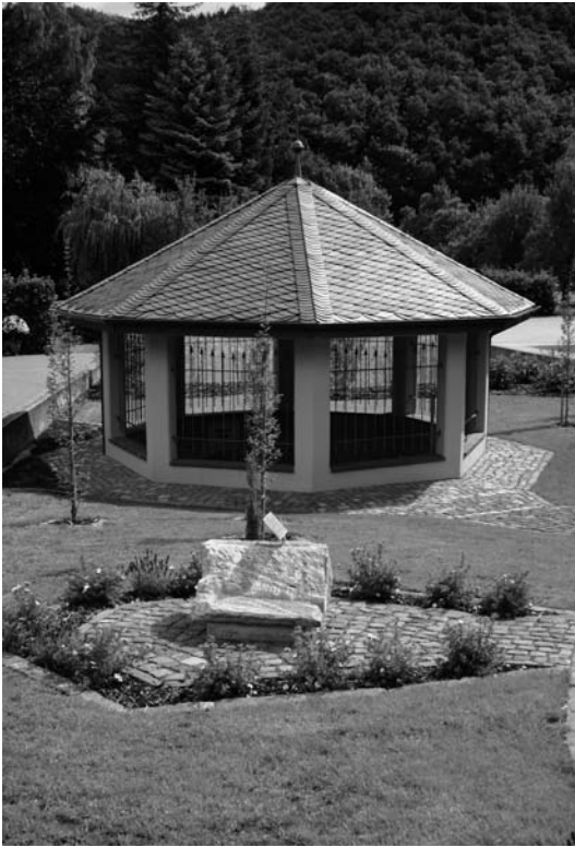
Rheinbach. Außenansicht des römischen Sammelbeckens © Fotos: Klaus Grewe, LVR
