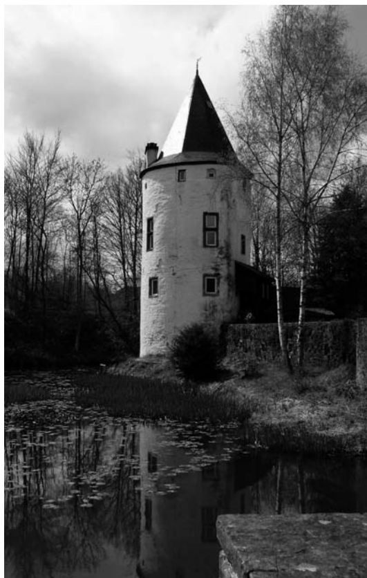
Abb. 3: Wasserburg Dreiborn, Stadt Schleiden; Südturm der ehemals vierflügeligen Hauptburg, 14./15. Jahrhundert.
