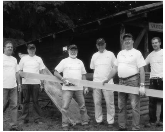
OG Gillenfeld. Aktiv vor Ort waren die Gillenfelder Eifel- freunde bei der Renovierung von zwei Schutzhütten. © Foto: OG Gillenfeld
