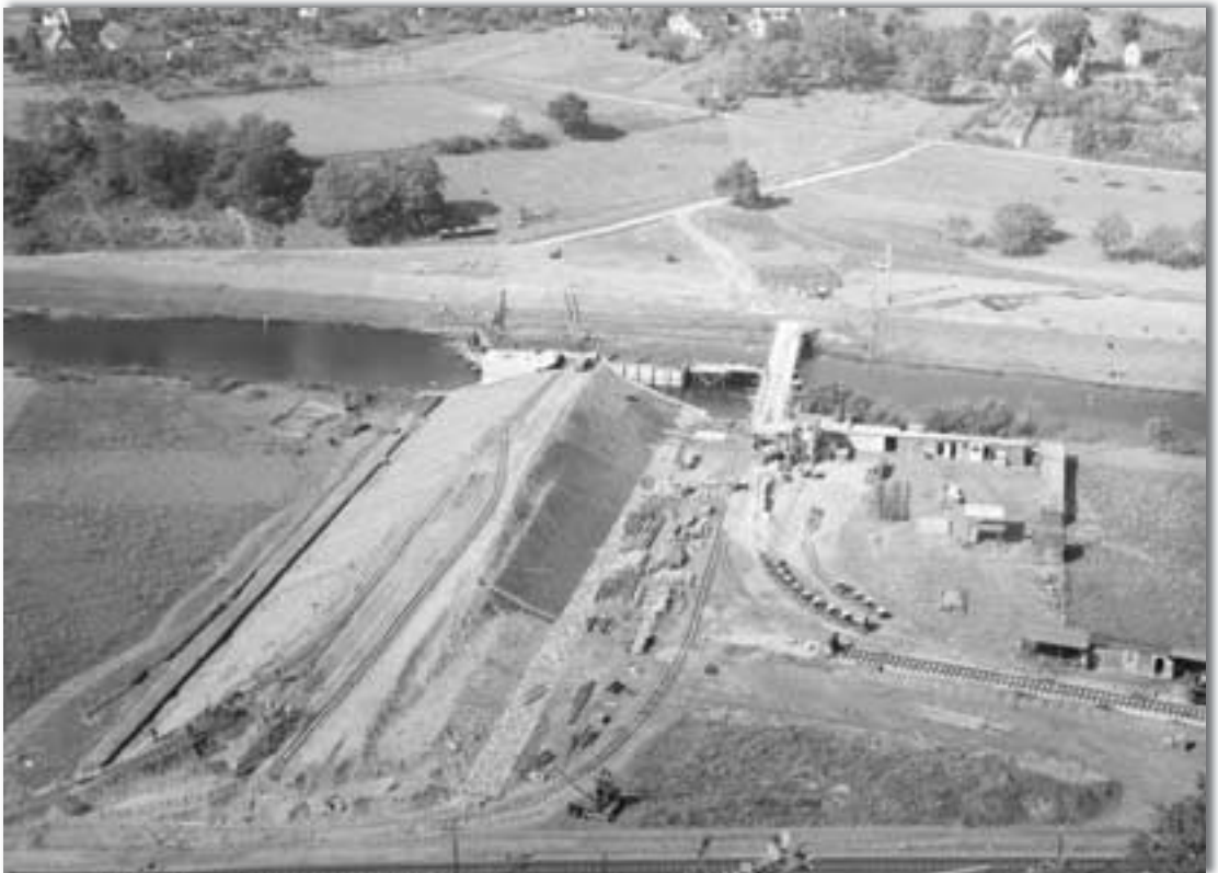
Der Bau des Staubeckens Obermaubach: Der Dammkörper entsteht.
