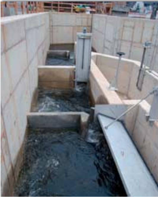
Einlaufbereich der Fischpassage im Betongerinne am oberen Ende: Deutlich sind die Schlitze zu sehen, durch die sich das Wasser abwärts strömend ergießt.
