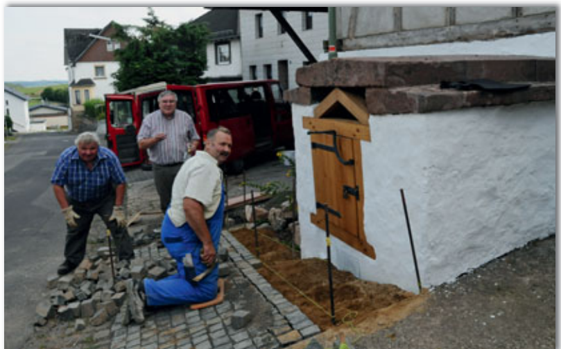
Ripsdorf. Pflasterarbeiten vor dem Brunnen Fotos: © Josef Schmitz
