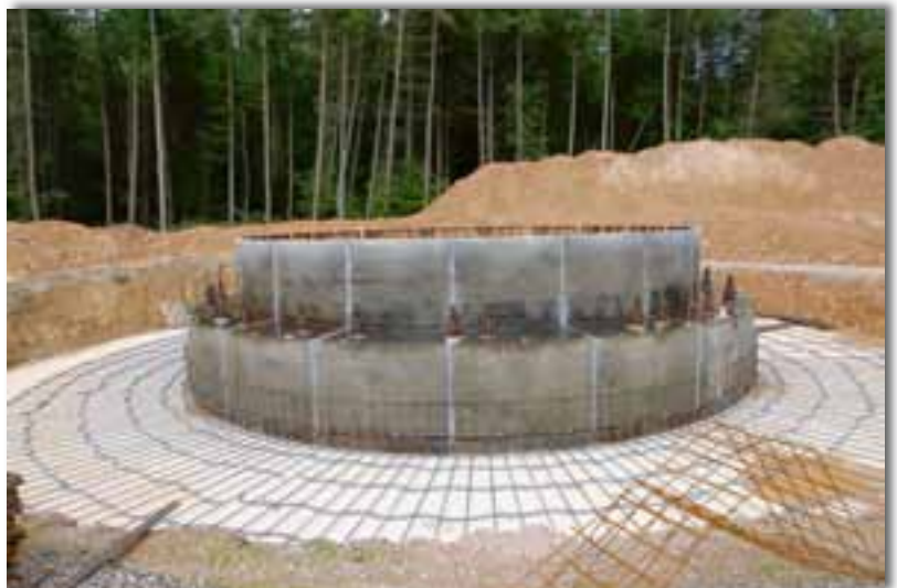
...dafür sind massive Betonfundamente herzustellen...
