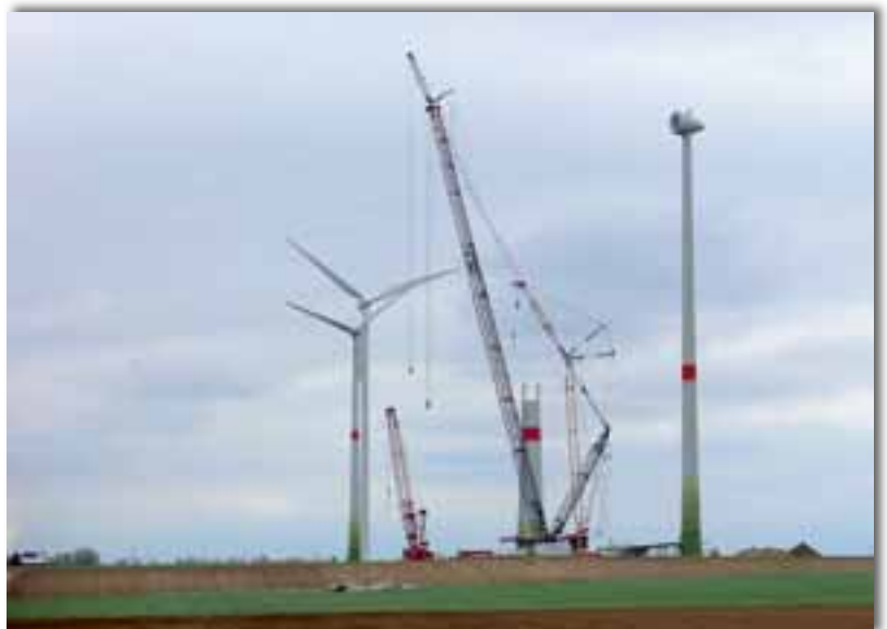
Eine typische Windkraft-Baustelle
