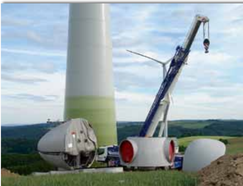
Die Nabe eines Windrades wird montiert.
