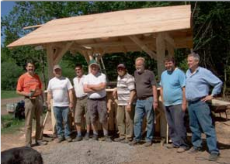
Oberes Kylltal. Die fleißigen Helfer des Eifelvereins und Betriebsinhaber Weinand bei den Arbeiten zur Erstellung der neuen Schutzhütte. Foto: TI Oberes Kylltal
