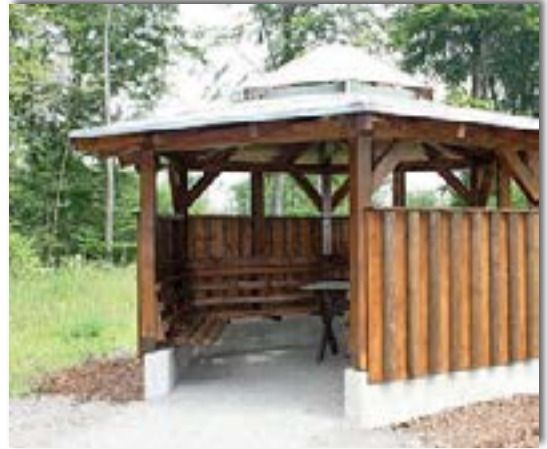
Fertige Schutzhütte in Hellenthal
