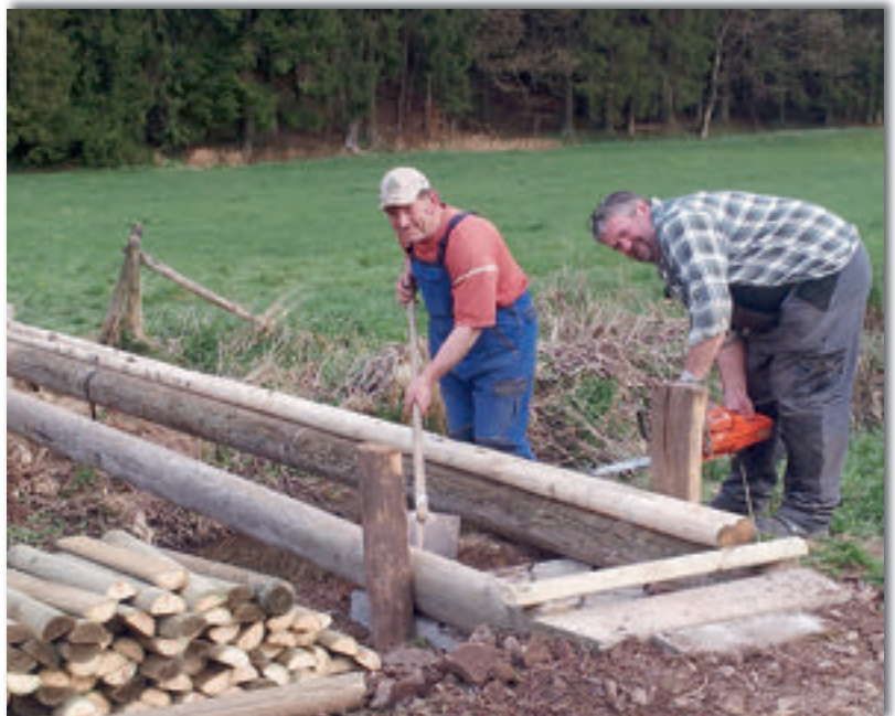
OG Bleialf. Die Hubertbrücke wird komplett erneuert. Foto: Peter Berens
