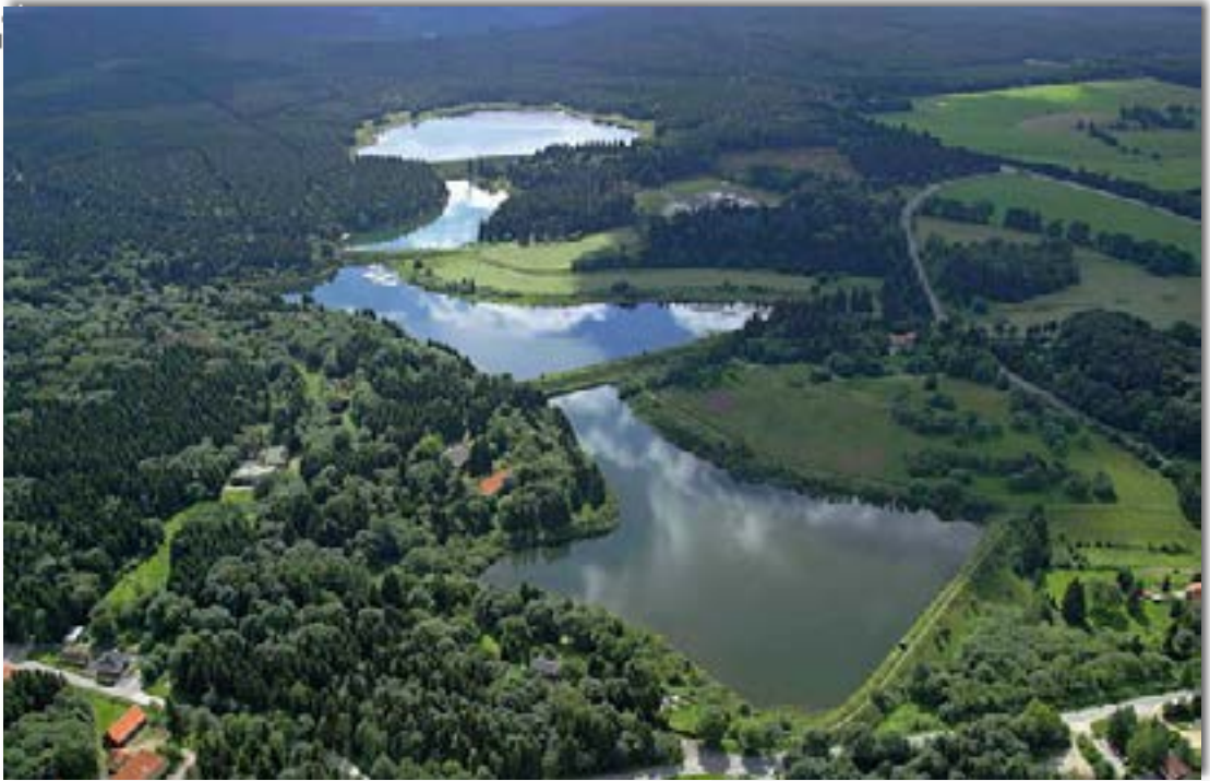
Teichkaskaden der Oberharzer Wasserwirtschaft bei Clausthal-Zellerfeld
