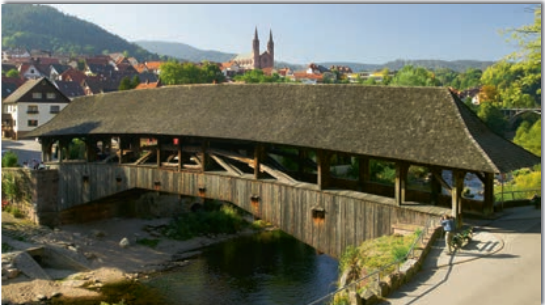
Die Historische Holzbrücke über die Murg in Forbach (Etappe 3)
