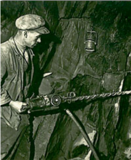
Besonders die Bohrarbeiten waren kräftezerrend...
