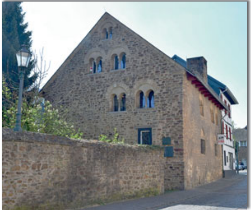
Das Romanische Haus in Bad Münstereifel ist ein herausragendes Baudenkmal in der Region. Foto: Karin White-Rahneberg, LVR
