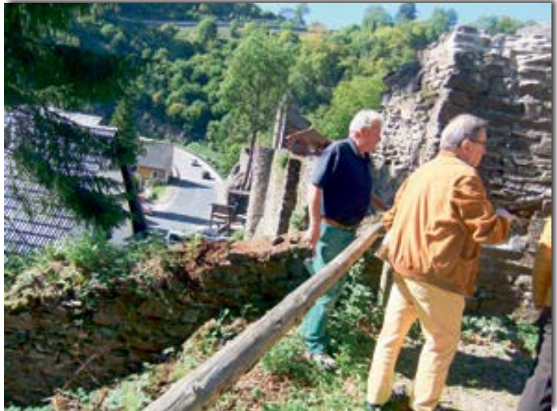
Manderscheid. Im Jahre 2015 begannen die Sicherungsmaßnahmen unter Leitung von Walter Densborn. Foto: Manfred Rippinger
