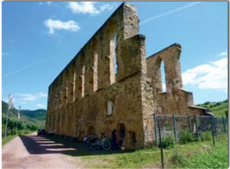
OG Koblenz. Klosterruine Stuben bei Bremm an der Mosel
