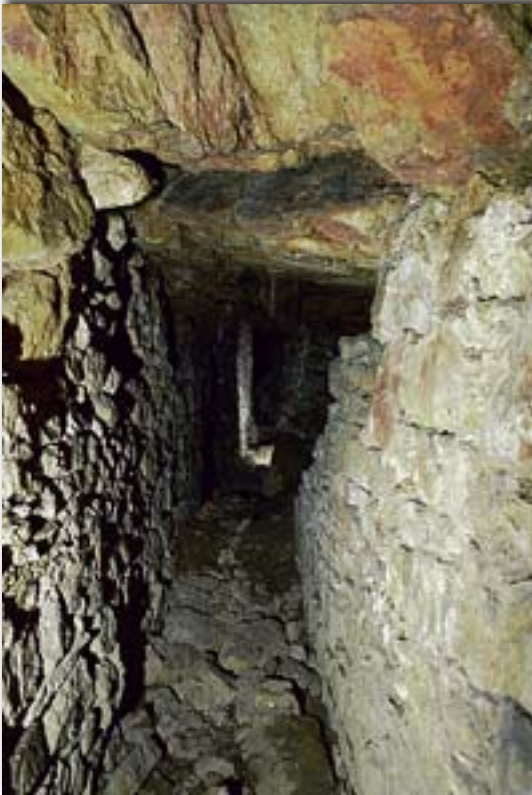
Blick in den Tiergartentunnel nach der Freilegung
