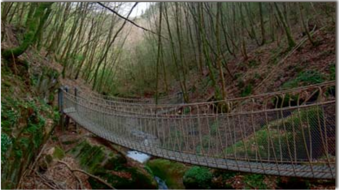
Höhepunkt im Butzerbachtal ist eine 30 m lange Hängebrücke.
