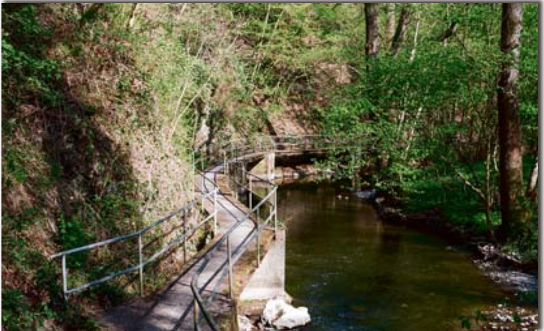
Abb. 7: Steg über dem Elzbach
