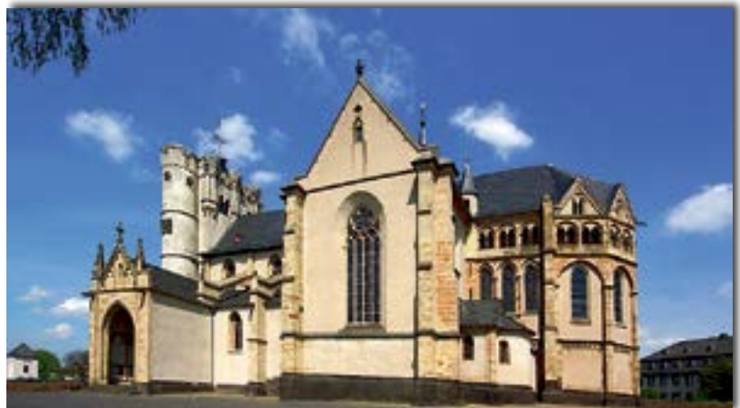
Abb. 1: Südostansicht der Kollegiatstiftskirche Foto: Matthias und Sonja Hochhausen
