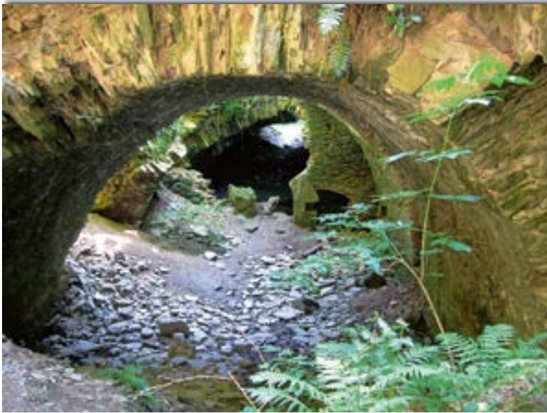
Traben-Trarbach. Gewölbekeller Mont-Royal Foto: Lutz Reichardt
