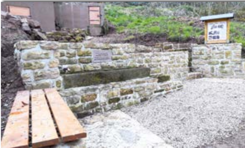
OG Mettendorf-Sinspelt. Geschafft, die Renovierung des Zapfenbrunnens ist fertig! Foto: Reinhold Hoffmann
