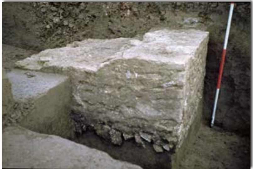
Meckenheim. Pfeilerfundament der ehemaligen Aquäduktbrücke über den Swistbach Foto: Klaus Grewe
