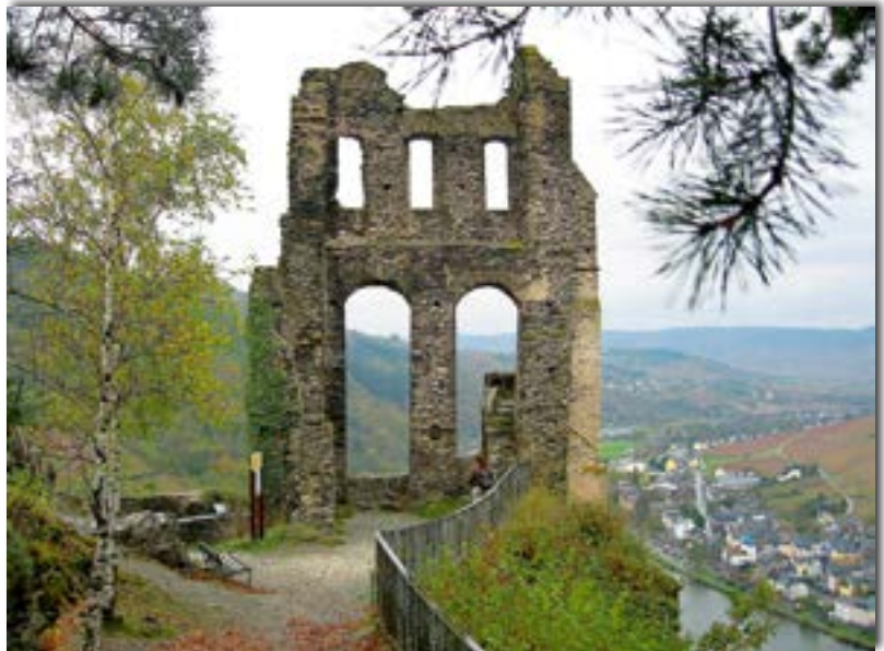
Traben-Trarbach. Fassade des Kommandantenlogis auf der Grevenburg Foto: Lutz Reichardt
