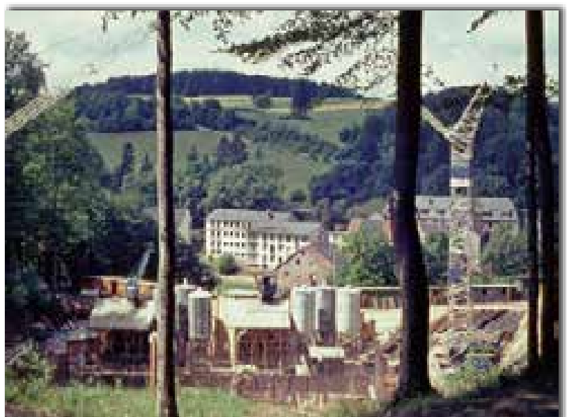
Die Baustelle, im Hintergrund die weißen Gebäude des Hermann-Josef-Hauses (Aufnahme 1962)
