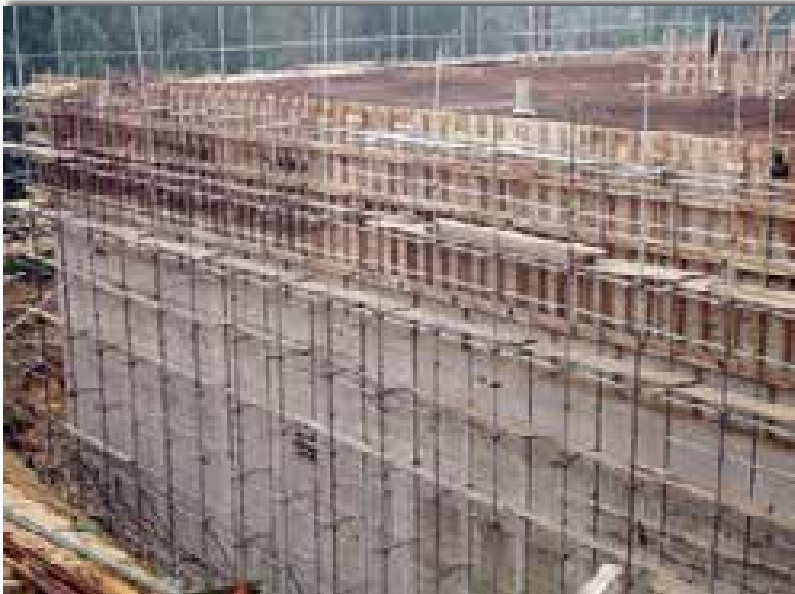
Der Rohbau ist fertig (Aufnahme 1963)
