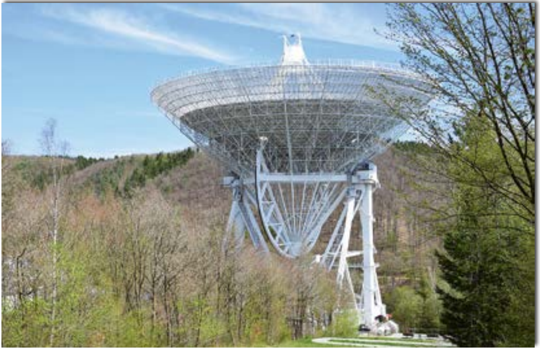
Abb. 8: Das Radioteleskop Effelsberg begeistert mit seiner schieren Größe: Der Parabolspiegel des 3.200 Tonnen schweren Kolosses misst 100 Meter Durchmesser. Foto: Jan Krister Joakim Batzer
