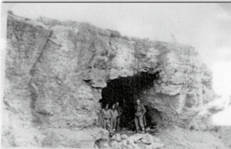
Abb. 4: Gruppe von GIs im Eingang des Teufelslochs Foto: Archiv Lutz Künster
