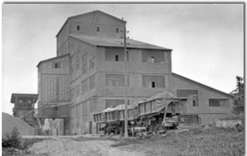
Abb. 6: Aufbereitungsanlage Horm Foto: Archiv Lutz Künster
