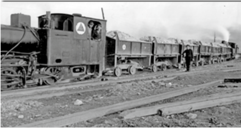
Abb. 7: Abfahrt von der Aufbereitungsanlage Horm zum Hülberg Foto: Archiv Lutz Künster
