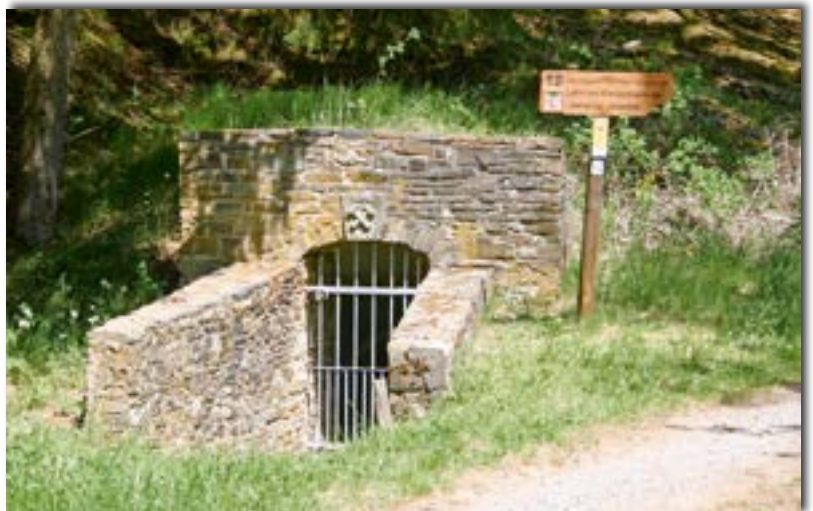
Abb. 6: Mundloch des „Schwalenbacher Stollens“ Foto: K. Piecha
