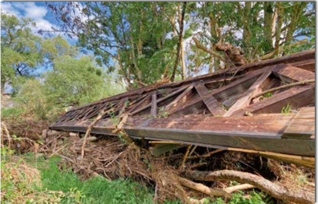
Irreler Wasserfälle: Die Holzbrücke ist weggerissen und 1,5 km Prüm abwärts völlig zerstört angeschwemmt worden ... Foto: Karl-Heinz Fellmann, OG Bitburg
