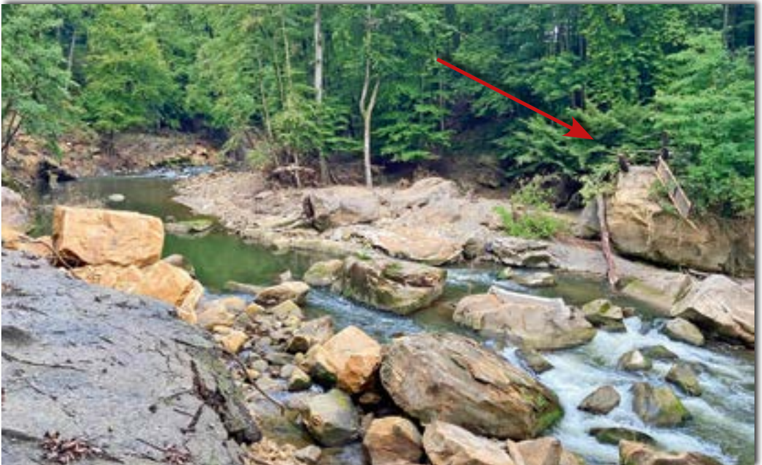
... Auch die markanten Felsbrocken, welche die Wasserfälle prägten, konnten der Wucht des Wassers nicht widerstehen. Sie wurden einfach mitgerissen. Der rote Pfeil zeigt das ehemalige Widerlager der Brücke. Foto: Karl-Heinz Fellmann, OG Bitburg
