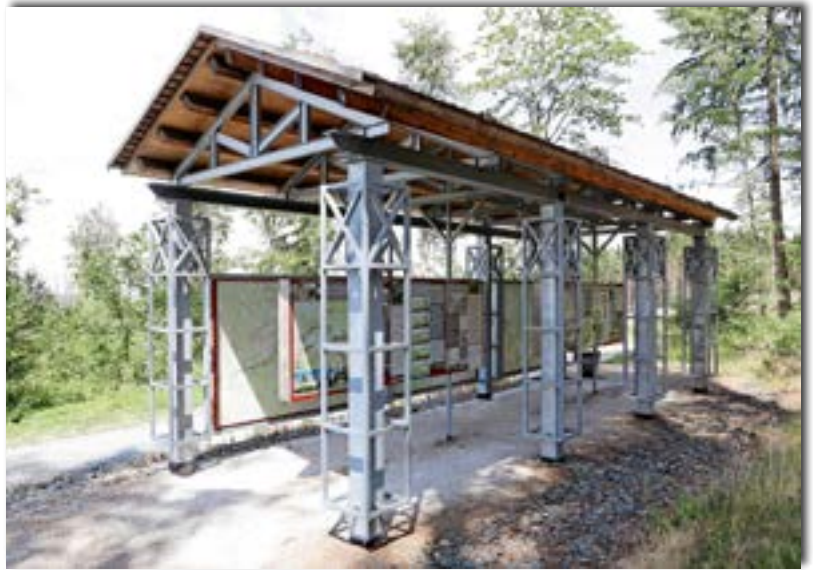
Abb. 2: Der Limes- Informationspavillon Foto: Limeserlebnispfad gGmbH
