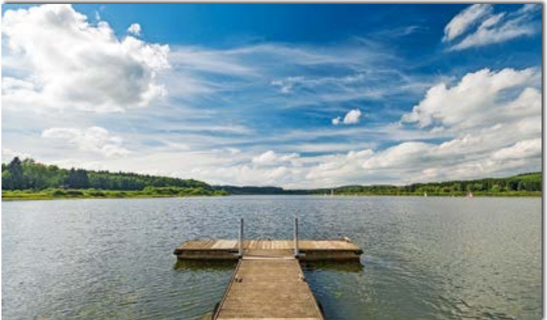
Abb. 1: Die Krombachtalsperre. Neben der Stromerzeugung dient sie dem Hochwasserschutz und der Freizeiterholung.
