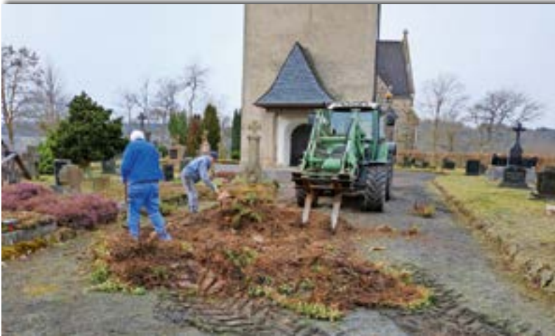
Abb. 2: Arbeitsbeginn mit schwerem Gerät im Feb. 2021
