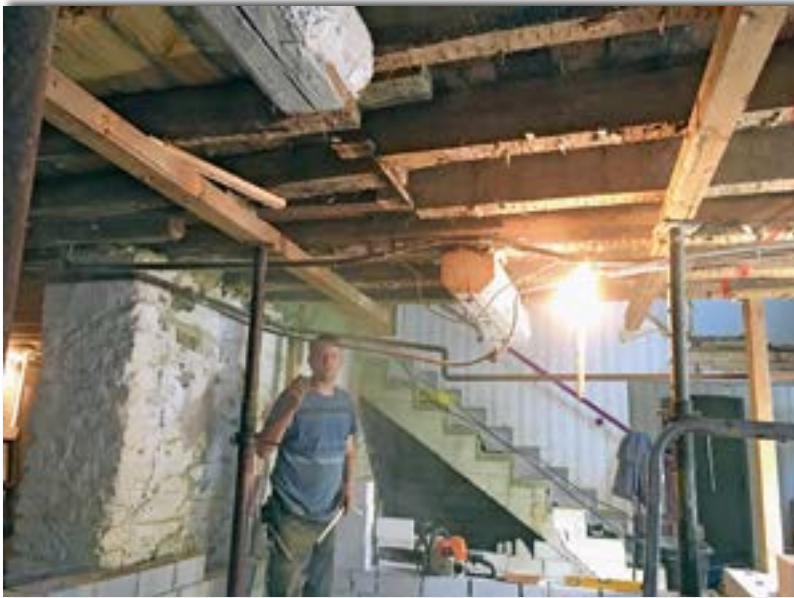
OG Rott. Entfernung der maroden Tragebalken Foto: Eifelverein Rott
