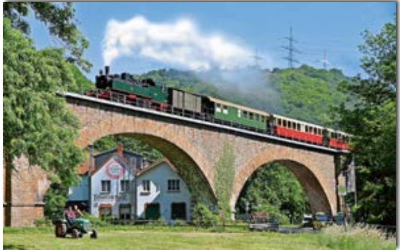
Abb. 6: Der Vulkan-Express überwindet auf 18 km Länge 400 m Höhenunterschiede. Foto: Walter Brueck
