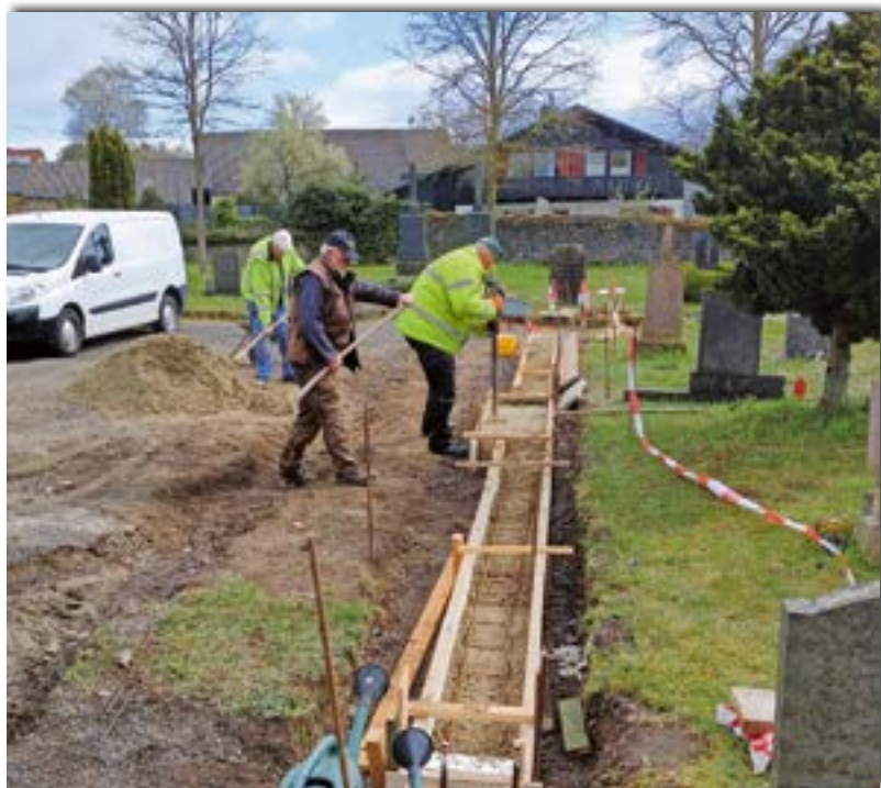
Abb. 3: Arbeiten am Streifenfundament
