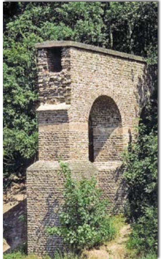
Abb. 13: Rekonstruierte Pfeiler der Aquäduktbrücke in Vussem Foto: Klaus Grewe
