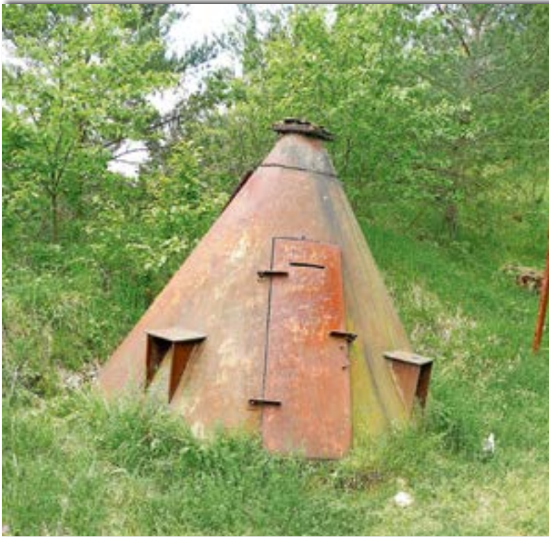
Abb.9: Die ehemalige Schutzhütte für das Sprengpersonal im Kalksteinbruch Sötenich
