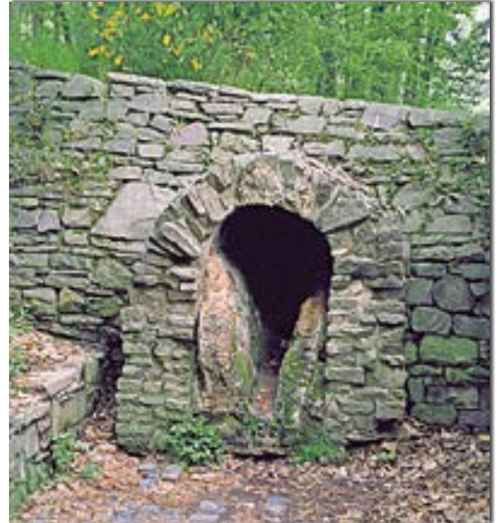
Abb. 1: Aufschluss des Römerkanals mit mächtigen Kalksinterablagerungen in Euskirchen-Kreuzweingarten Foto: Klaus Grewe
