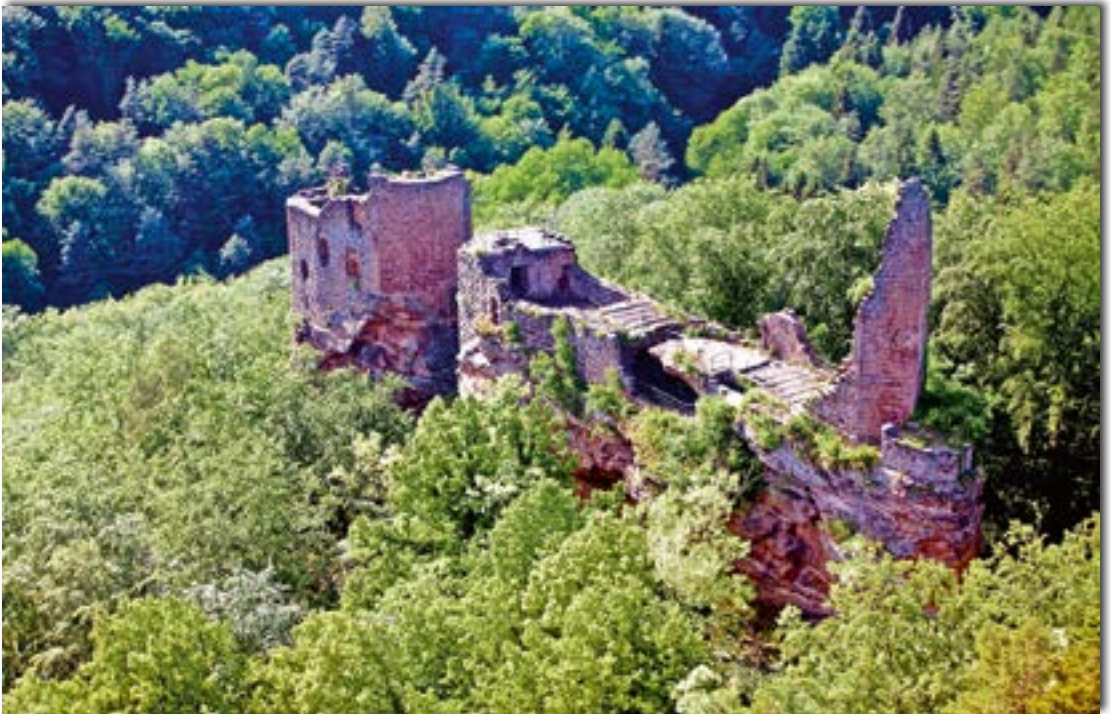
Abb. 7: Wasigenstein/F, Burgruinen aus der Mitte des 13. Jahrhunderts auf einer durch eine tiefe Schlucht geteilten Felshebung. Höher gelegen die „alte Burg“, westlich die „neue Burg“. Zerstörungen im Dreißigjährigen Krieg. Überreste: In Felsen gehauene Treppen, Gemächer und Ringmauern. Foto: Kurt Groß, Tourist-Information Dahner Felsenland
