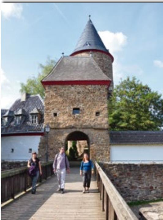
Abb. 7: Rheinbach. Im Mauerwerk des Hexenturms ist massenhaft Römerkanalabbruch verbaut worden.
