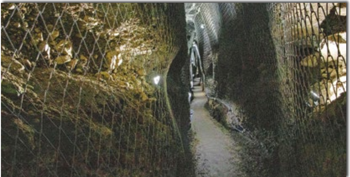
Die schmalste Stelle im Stollen.
