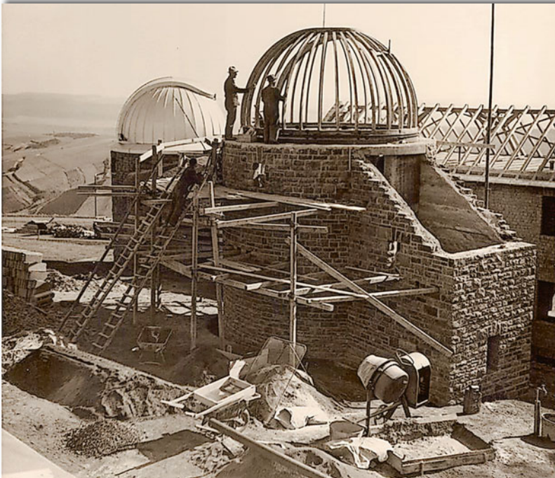
Montage der Kuppel von Turm 2 im Oktober 1953 Foto: Archiv Dr. Christoph Schmidt
