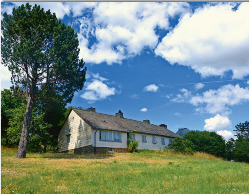
Heute haben einige der unter Denkmalschutz stehenden Gebäude den Charme eines Lost Place. Foto: Dr. André Uzulis
